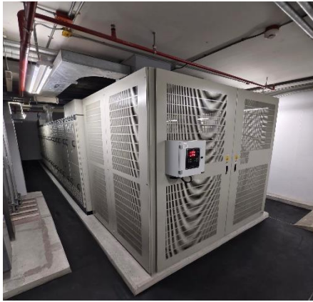
รูปที่ 2-38 หม้อแปลงไฟฟ้า
