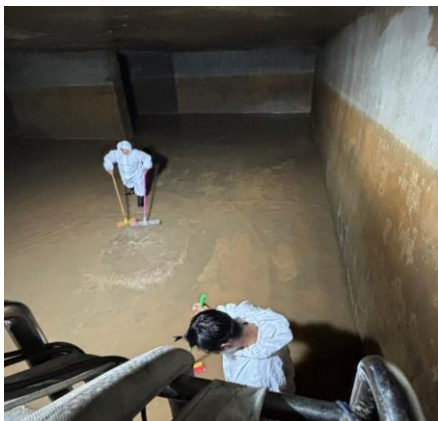
รูปที่ 2-67 การล้างถังน้ำสำรอง
